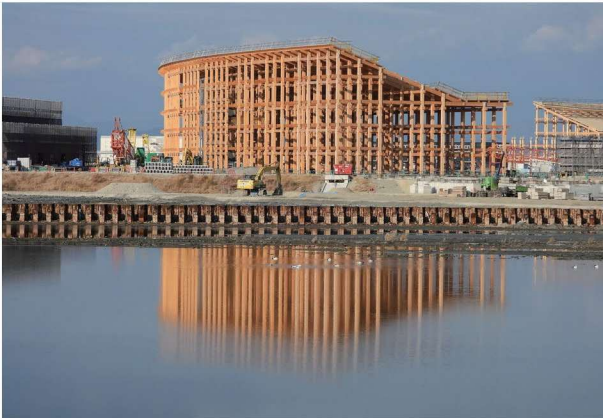
2023年12月巨大リングが立ち始めた湿地に、この年も多くのツクシガモがやってきた。しかし数は例年の3分の1。調査の車は警戒するが、工事車両は気にしない。
