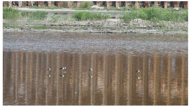
写真-3 大屋根リング建設現場ぎわの浅瀬が営巣場所。工事により干潟が狭くなったといっても鳥のいるところまではかなり遠い。2024.8.15
