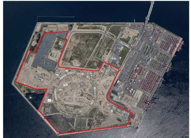
写真-3 2024年の夢洲：南部の湿地等が地盤改良工事で固められている。(万博開催時には、全面が1~2mの水深に海水が張られ、シギ、チドリに適する場所にはならない。)
