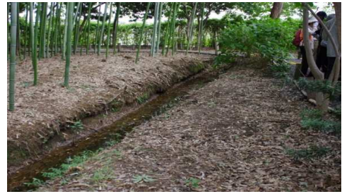
竹の根を切るための溝
