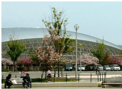
東大阪市立体育館
